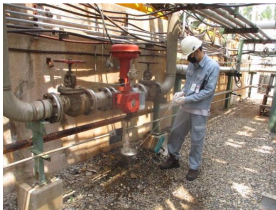
จุดระบายน้ำเข้าระบบบำบัดน้ำเสีย (Receiving Tank) ก่อนเข้า Equalization Cooler
